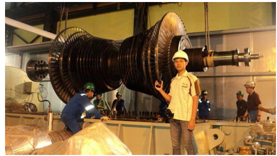
Gambar 4. Turbin pada PLTP Ulubelu Unit 1 saat Overhaul (Sumber : PLTP Ulubelu )
