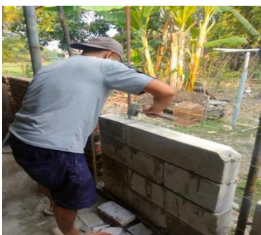
Gambar 5. Pemasangan Bata Ringan
