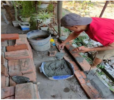
Gambar 3. Pemasangan Bata Merah
