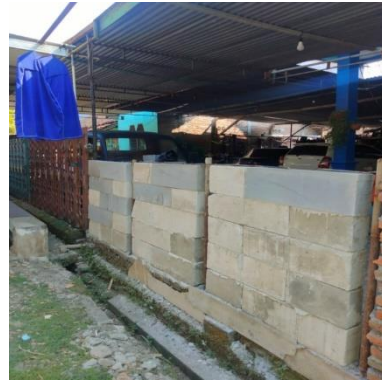
Gambar 6. Hasil Pemasangan Bata Ringan
