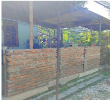
Gambar 4. Hasil Pemasangan Bata Merah
